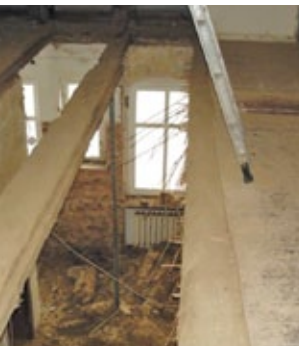
Deckensanierung
