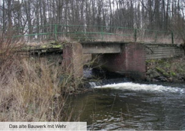
Das alte Bauwerk mit Wehr
