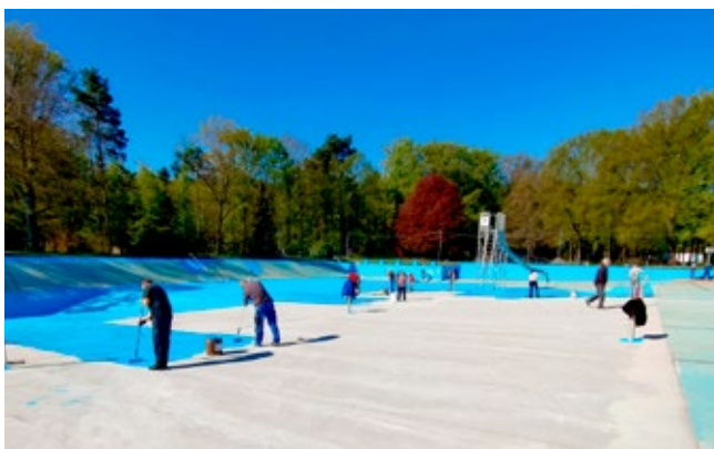
Beim finalen Anstrich wurde von 54 freiwilligen Helfern die Beckenfarbe aufgetragen – Teamarbeit pur!
